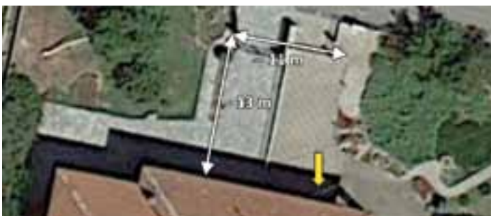
Fig. 8 - Vista satellitare di cortile e parte del tetto dell'abitazione dei testimoni. Sono indicate le dimensioni approssimative del cortile e una vista dall'alto del cavo (Fonte: Google Maps).
