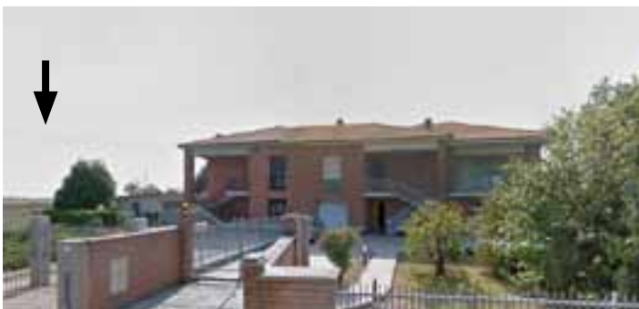
Fig. 7 - Prospettiva frontale odierna dell'abitazione dei testimoni con indicazione del cavo (cfr. Fig. 6) (Fonte: Google Maps).
